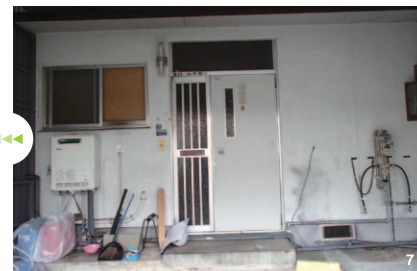
7・8 外壁の汚れと以前から気になっていたむき出しの配管。玄関ドアは施主様の希望で引き戸に交換。気になっていた配管も埋設し、スッキリとした玄関前に
